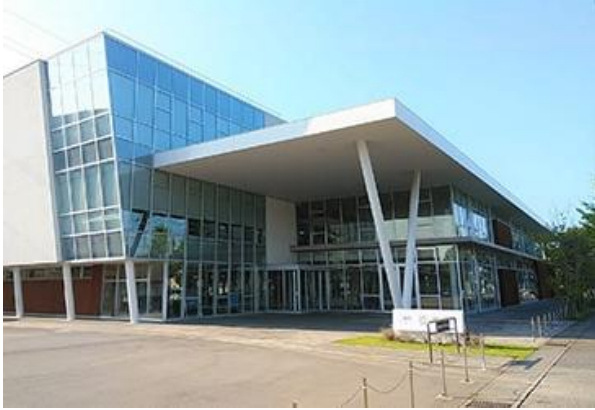
金沢工業大学 41 号館 (夢考房)
